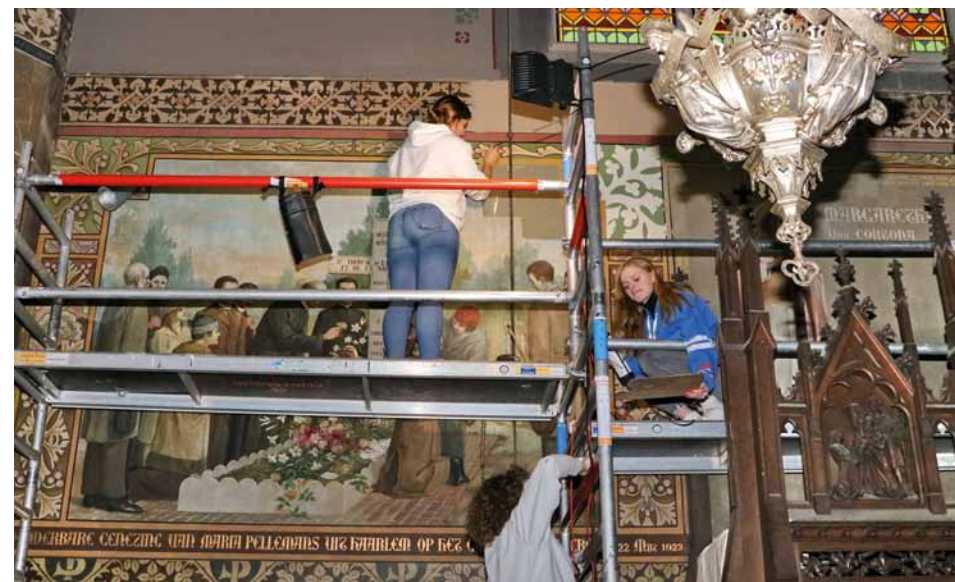
Het restauratiewerk in volle gang. (Foto: Henk van Dijk)
